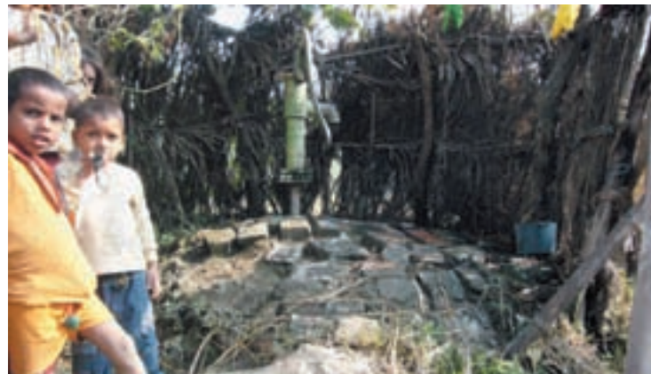
चित्र २०: धनुषा जिल्लाको कटरैट गाविसमा माटो र ईँटाबाट अग्लो बनाइएको स्थानमा निर्माण गरिएको पानी तान्ने पम्प ।
