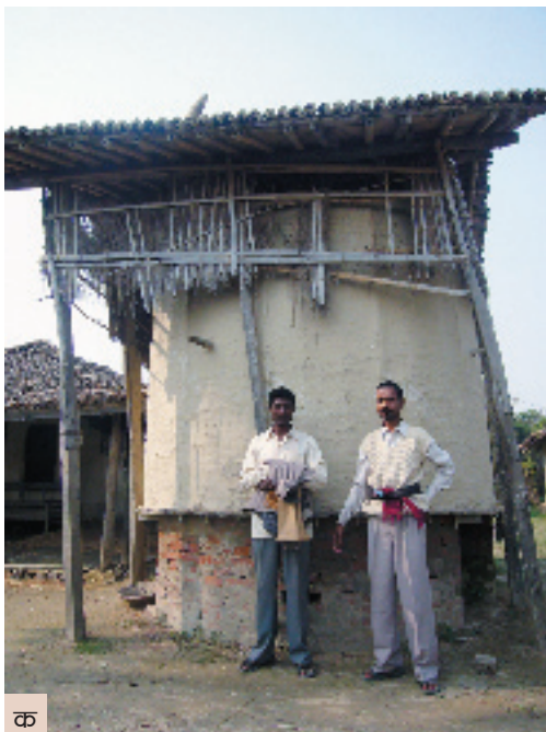
चित्र १३ : फरक प्रकारका अन्न भण्डारहरू : क) सर्लाही जिल्लाको फूलपरासी गाविसमा ईटाको जग राखेर बाहिर बनाइएको अन्न भण्डार, ख) बाँसबाट बनाइएको अन्न भण्डार, ग) महोत्तरी जिल्लाको सिंग्याही गाविसस्थित एक घर भित्र माटो र सठ्ठाको प्रयोग गरी बनाइएको अन्न भण्डार ।
