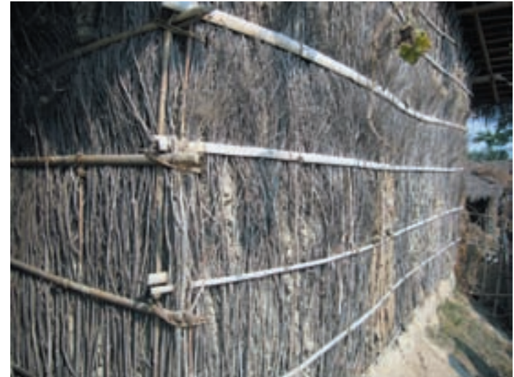
चित्र ६ : कोसेबालीको सुकेका बोटहरूबाट निर्माण गरिएका स्थानीय घरका गिताहरू, कटरैट गाविस, धनुषा जिल्ला
