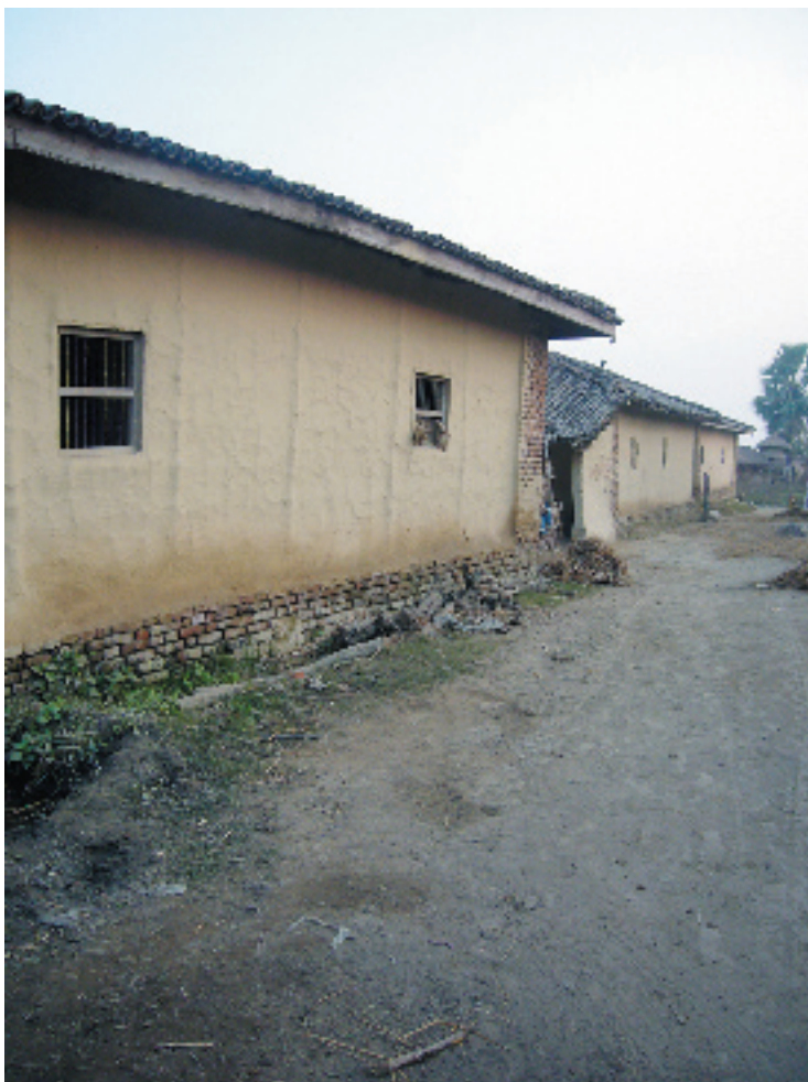
चित्र १० : रौतहट जिल्लाको भैंसरवा गाविसस्थित ईटाको जग सहितको माटोको घर
