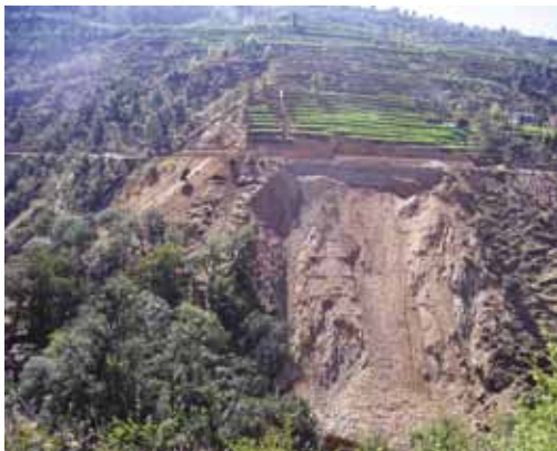
▲ भू- प्रकोप: सडक निर्माणले क्षतिग्रस्त पाखा (बझाङ जिल्ला)
